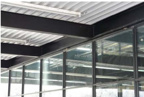
**Fig. 19** : Détail (jonction de la toiture et du mur-rideau de l'atelier mécanique, BPTE, octobre 2008
